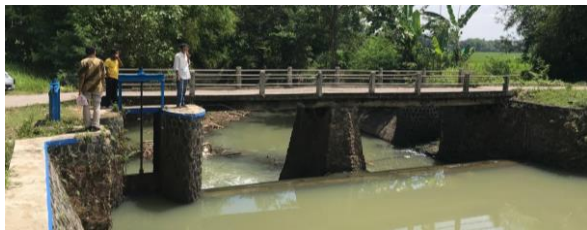
Gambar. 2. Tampak eksisting jembatan
