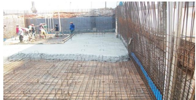
Gambar 3. Pemasangan waterstop dinding dan pelat lantai
